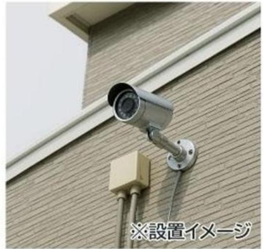
カメラをしっかり固定するため、外壁の材質に合わせ、最適なアンカープラグをご利用下さい。
